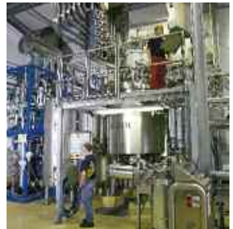
Das Planatol Adhesive-Rührwerk in Rohrdorf arbeitet computergestützt mit zwei unabhängig voneinander rotierenden Rührorganen. Hier werden Dispersionsklebstoffe, Schmelzkleber und vernetzte Polyurethan-Klebstoffe hergestellt.
